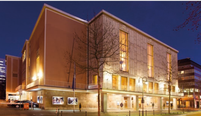
Opernhaus (Neubau), Heinrich-Heine-Allee 16A, 40213 Düsseldorf
