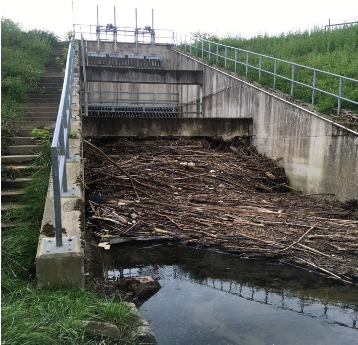
Abb. 20: Hochwasserrückhaltebecken Rospe am 27. Juli 2021 – Auslaufbauwerk wasserseitig nach Ablauf des Hochwassers aus dem Stauraum fotografiert (Aggerverband, 2021)
