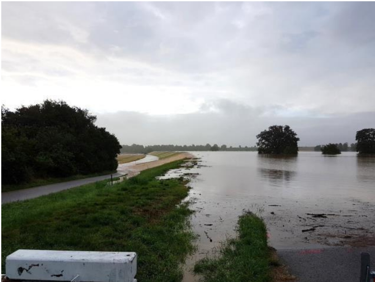
Abb. 18: Hochwasserrückhaltebecken Horchheim während des Hochwasser im Juli 2021 (Erftverband 39 )
