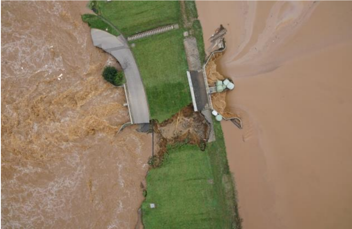
Abb. 19: Hochwasserrückhaltebecken Horchheim während des Hochwasser im Juli 2021 (Erftverband 39 )
