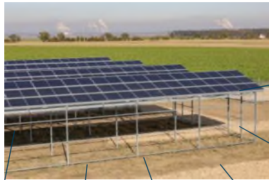
AgroPV-Forschungsanlage (Standort Alt-Morschenich)
