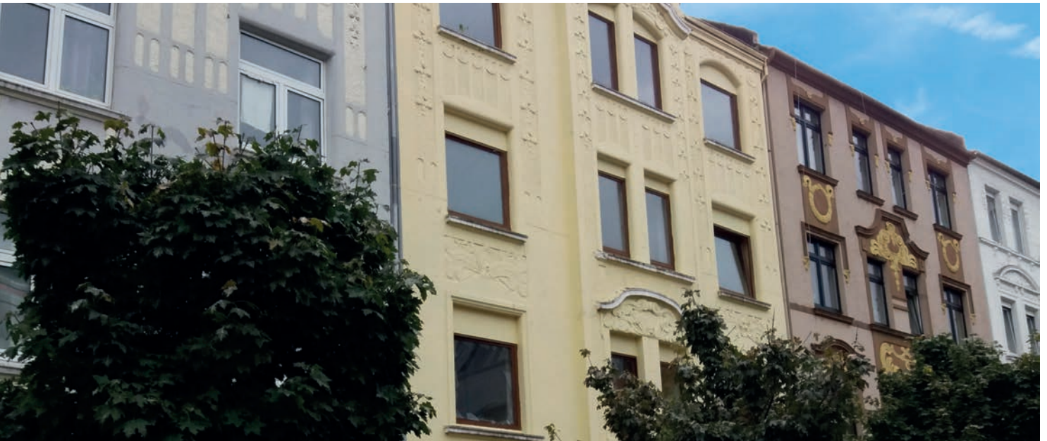
Abb. 35: Problemimmobilien in der Dortmunder Nordstadt
