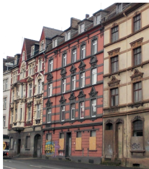
Abb. 44: Durch Zwangsversteigerung erworbenes Gebäude
