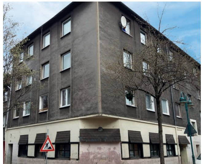
Abb. 41: Nach Abwendung einer Zwangsversteigerung freihändig erworbenens Gebäude in Duisburg
