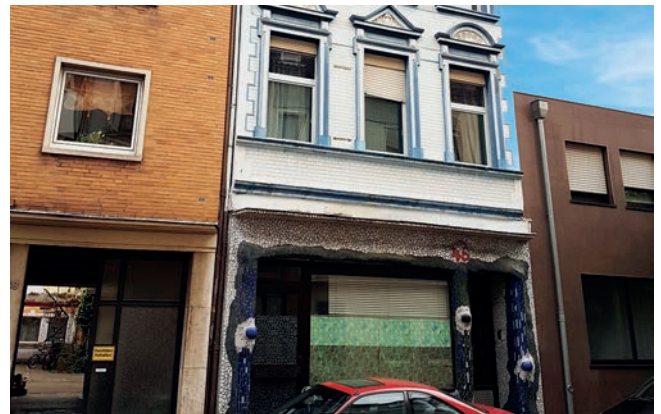
Abb. 24: Unbewohnbarkeitserklärung für ein Dachgeschoss wegen Brandschutzmängeln in Düren
