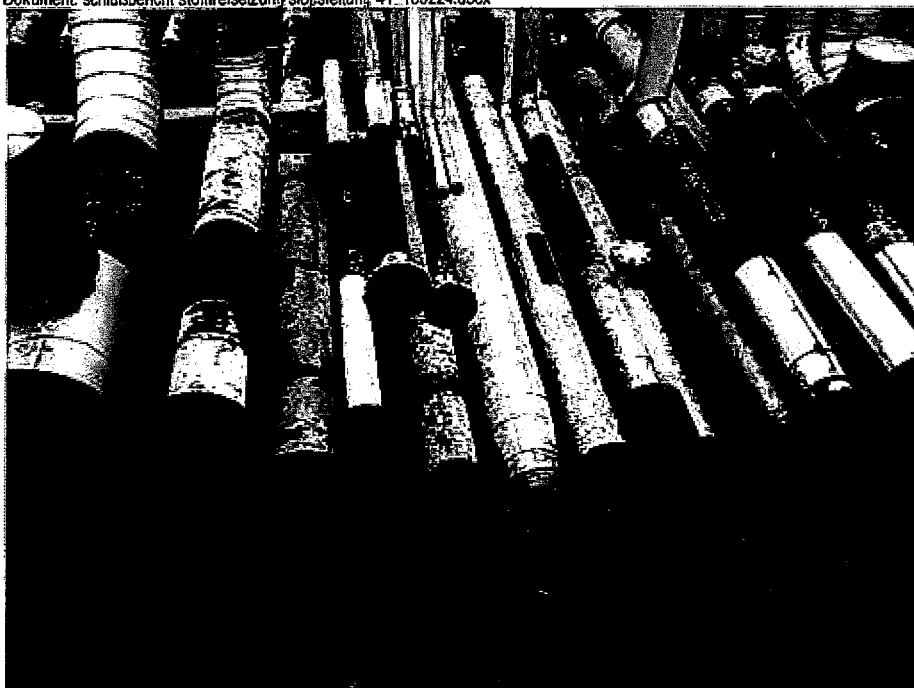
Abbildung 2 Rohrleitung 41 im Rohrgraben
