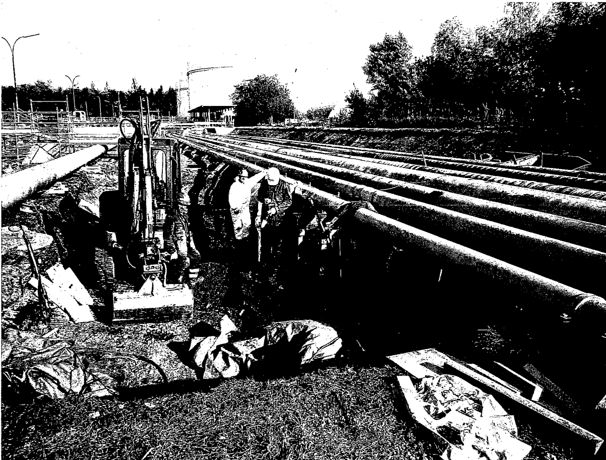
Abbildung 2 Rohrleitung 2532 Bereich der Stofffreisetzung
