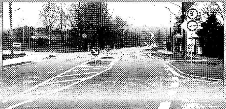
L 791 Bielefeld-Ummeln nach dem Einbau einer Mittelinsel
