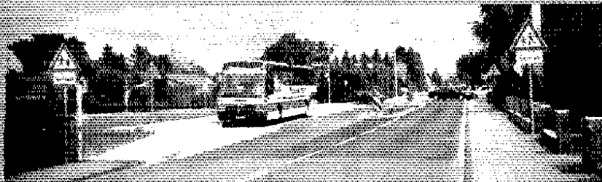
Bushaltestelle mit Hochbord und Mittelinsel, Hamm-Pelkum
