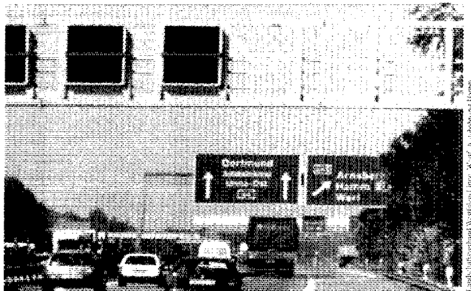
Wechselverkehrszeichenanlage auf der Autobahn A 44
